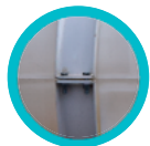
ANILLOS DE ACERO DE REFUERZO
